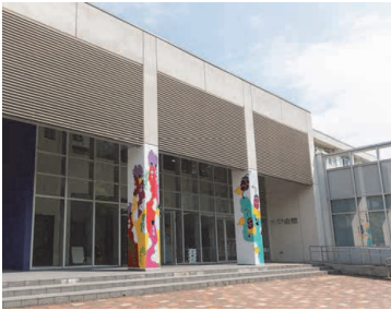
大学会館壁面 「砂漠のガーデン」
