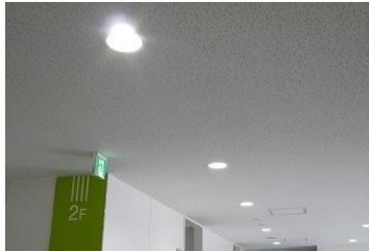
図 5-11 高効率照明器具(LED)の設置例(4号館)
