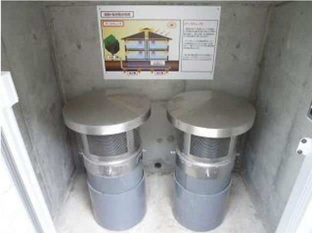
図 5-13 アースチューブの外気取入口
