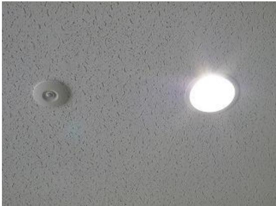
図 5-10 人感センサー付き照明器具の設置例(4号館)
