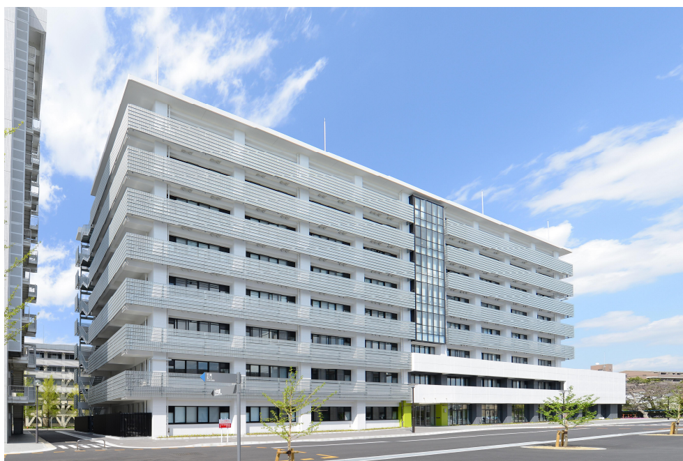
4号館スマートエネルギー研究拠点 外観
