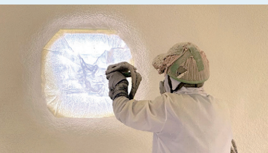
インスタントハウスの開口部の施工の様子
