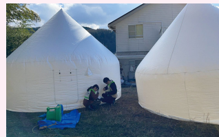
事務職員が屋外用インスタント ハウスを設置している様子
