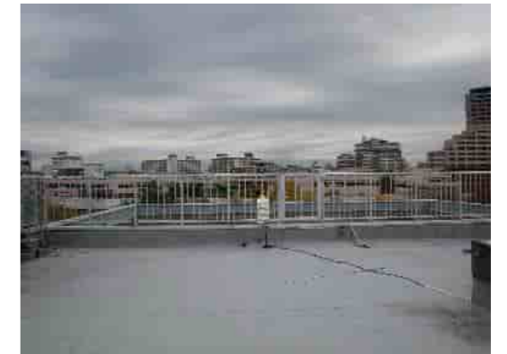
55号館屋上防水
