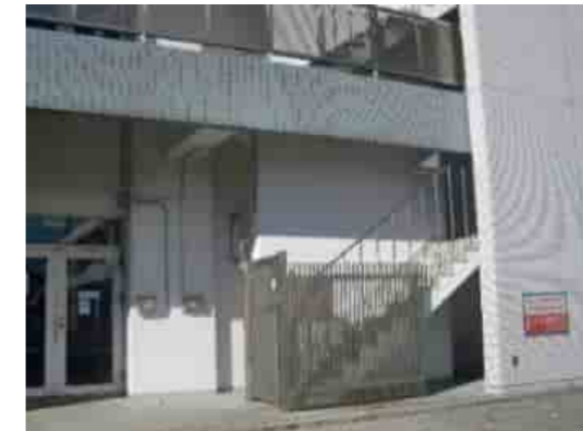
避難経路付近の外壁タイル
