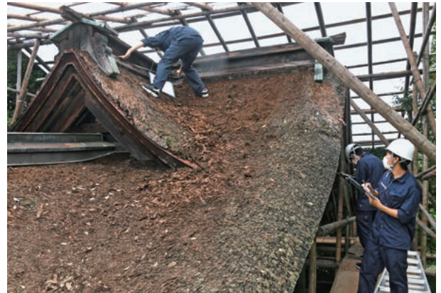
歴史的建造物修理に伴う実測調査
