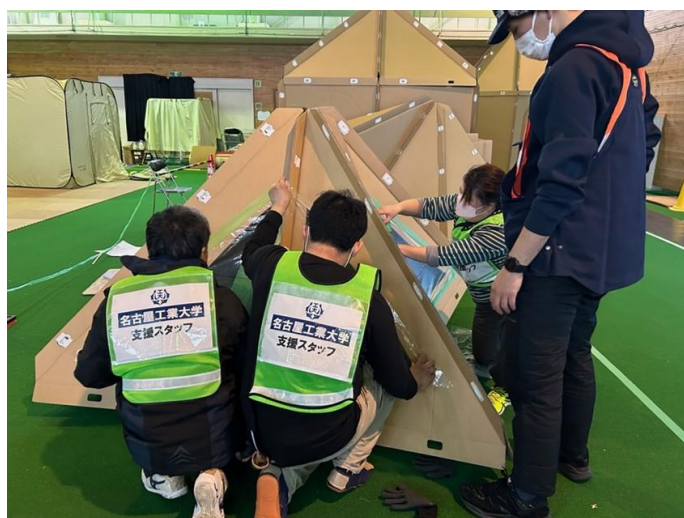
屋内インスタントハウスの組み立て作業
