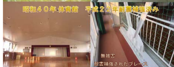
耐震補強されたブレース
