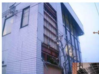
天井・外壁の脱落
