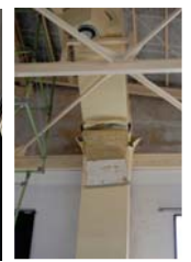
照明設備の被害
