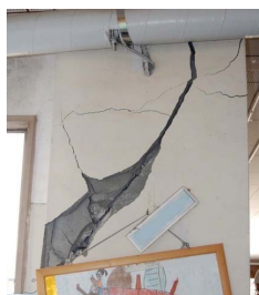
せん断破壊した柱 鉄筋が露出している
