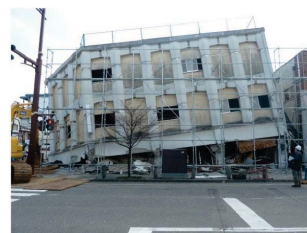
一階の層崩壊
