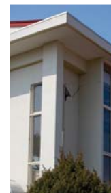
体育館の雑壁被害 構造体としてはほぼ健全
