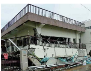
一階の層崩壊
