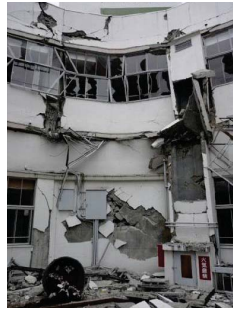
2階と3階が層崩壊
