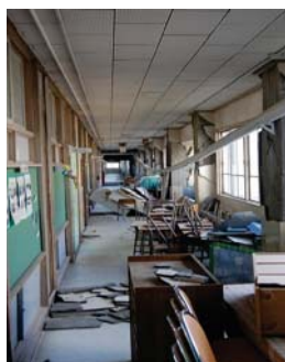
校舎内部 全ての柱がせん断破壊
