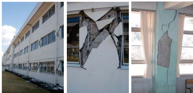
北側の柱が全て せん断破壊
