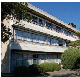
南側には大きな窓柱の損傷は小さい
