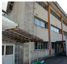
北側一階の柱が全てせん断破壊
