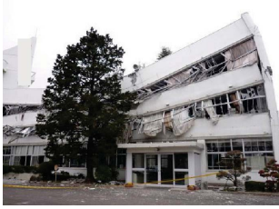
大学校舎の被害
