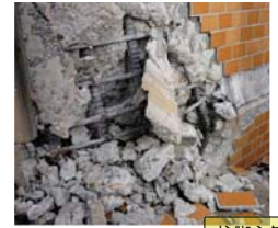
柱脚主筋の座屈
