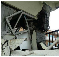
二階柱のせん断破壊
