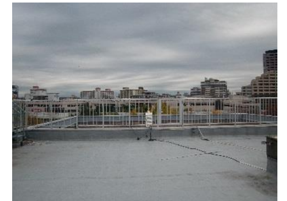
55号館屋上防水
