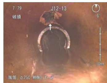
屋外排水管破損
