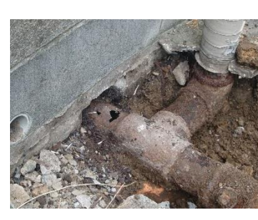
埋設管の腐食
