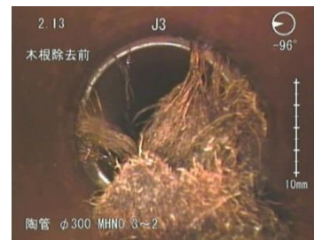
屋外排水管木の根の詰まり
