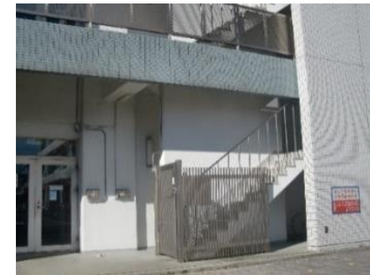
避難経路付近の外壁タイル
