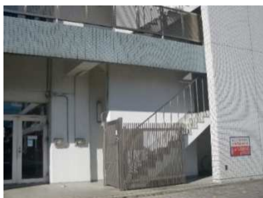
避難経路付近の外壁タイル
