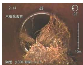
屋外排水管木の根の詰まり
