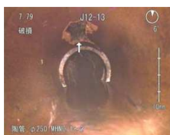
屋外排水管破損
