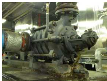
ポンプの劣化
