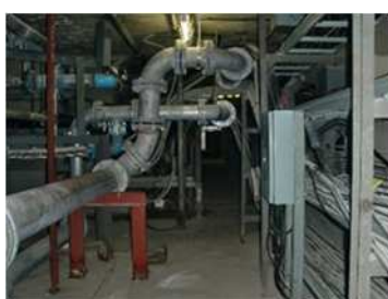
共同構配管・配線
