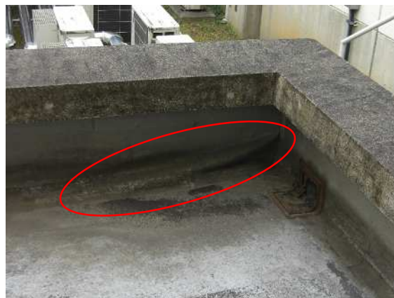
屋上シート防水
