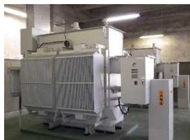
特高受変電設備
